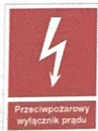
Rys.1. Prawidłowe oznaczenie zdalnego sterowania przeciwpożarowego wyłącznika prądu.
